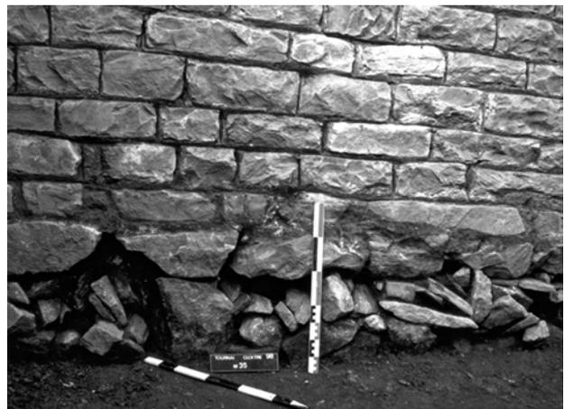
Fig. 13 – Site des cloîtres canoniaux : mur de terrassement du III<sup>e</sup> siècle.
