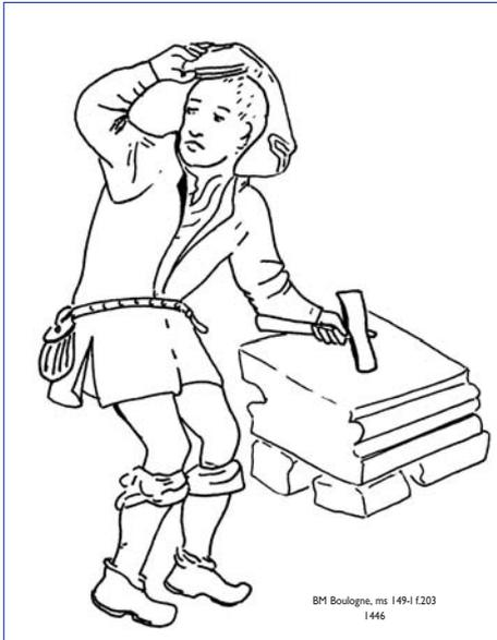
Fig. 3 — Utilisation d'un marteau taillant, 1446 (d'après Bibl. Mun. Boulogne-sur-Mer, ms 149-1, f. 203).
