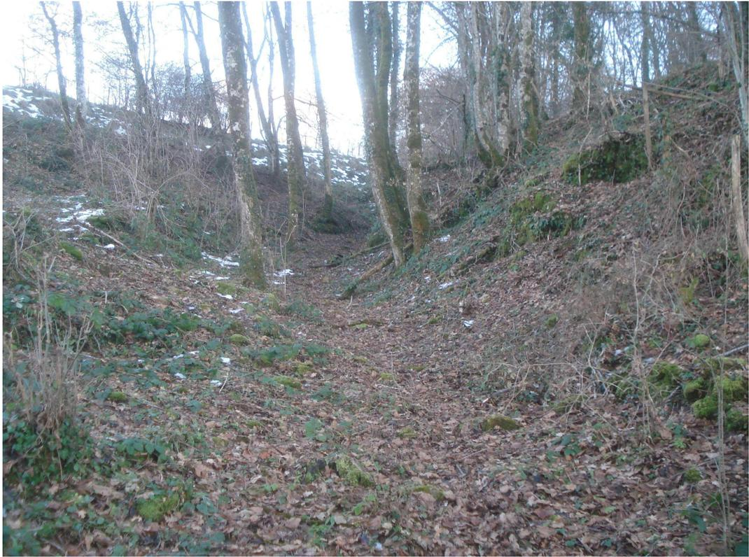
Point 5 : après le virage, le chemin a été creusé dans le terrain meuble (peut-être en partie de façon naturelle au départ, du fait du ruissellement), toujours pour conserver une pente acceptable. Au centre de l'image, derrière le bouquet d'arbres, apparaît un nouveau banc de roche qui a été taillé.
